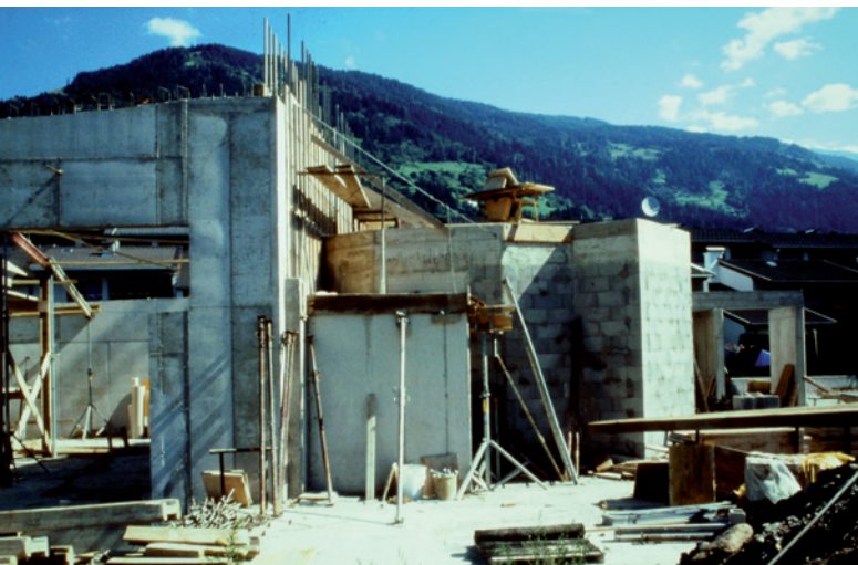
Koch International, Lienz während der Rohbauphase
