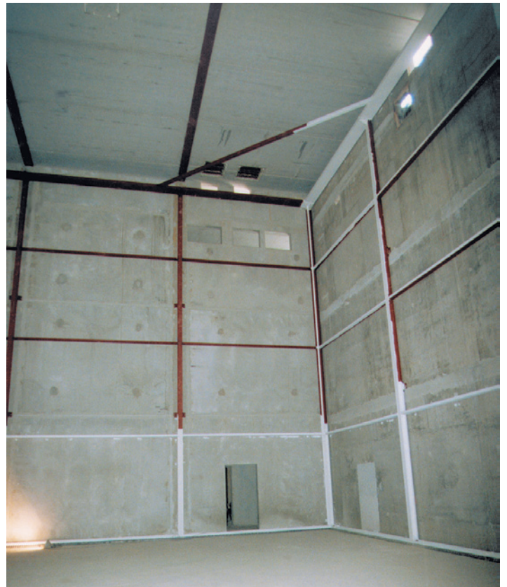
Das noch nicht ausgemauerte, elastisch gelagerte Stahlskelett einer massiven Vorsatzschale
