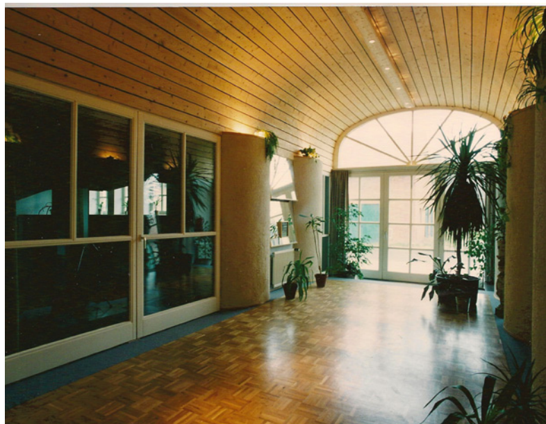
Principal Studios Münster: der kleine Aufnahmeraum ist mit einer gebogenen Schlitzplatten-Absorber-Decke ausgerüstet
