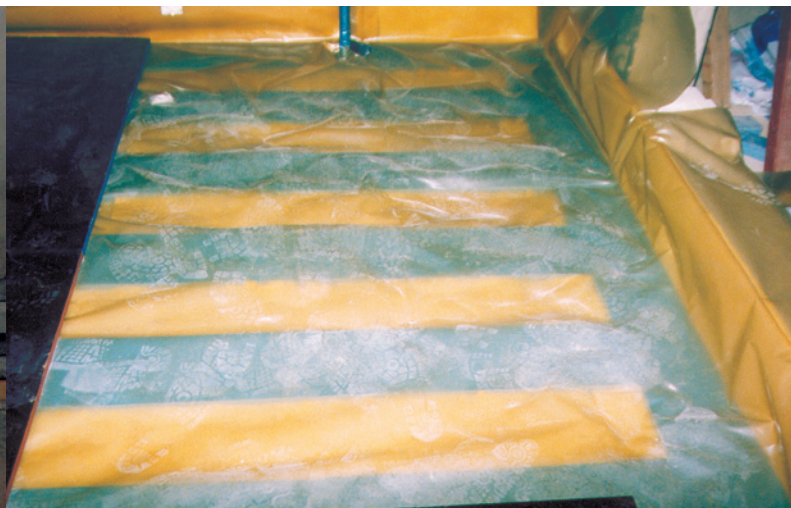
Elastomere Lagerung einer Bodenplatte: zu sehen sind die Elastomerstreifen unter einer Schutzfolie. Links und unten ist die verlorene Schalung erkennbar. Die gelben Streifen sind die Hohlraumdämmung mit Mineralfaser
