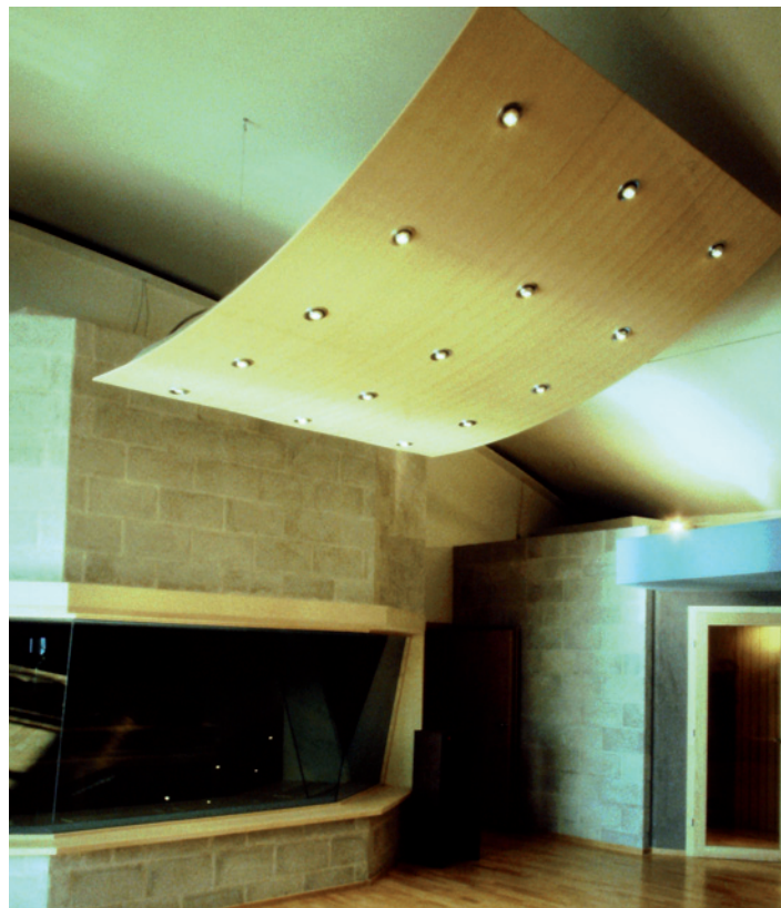
Großer Aufnahmeraum Koch International, an der Decke erkennt man das konvexe Akustiksegel
