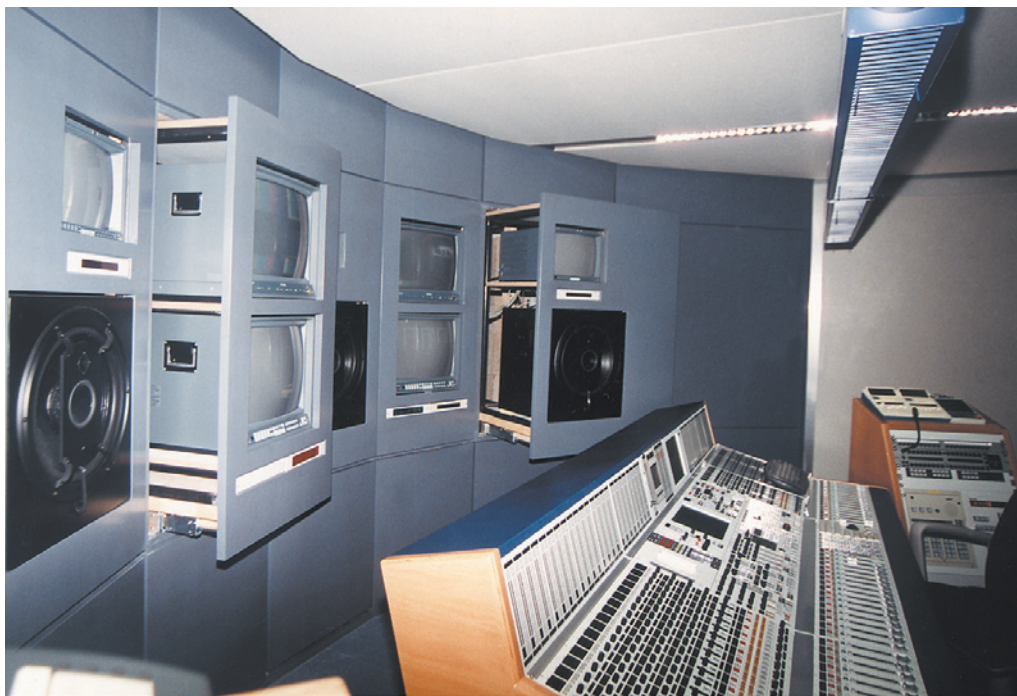
Südwestrundfunk Baden-Baden, FS-Regie 6: Hier zeigt sich die Problematik eines geringen Platzangebotes, die durch magnetisch geschirmte Lautsprecher und zu Servicezwecken herausfahrbare Schubladen gelöst wurde
