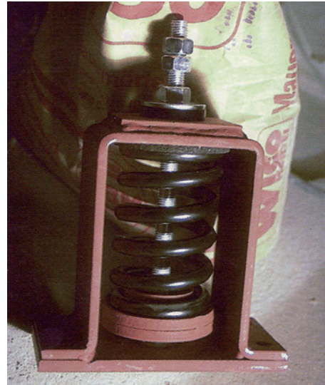
Einer der Federtöpfe, an denen die gesamte Regie im Violet Sound Studio in München hängt
