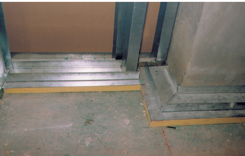
Auf Elastomer gelagerte Unterkonstruktion einer biegeweichen Vorsatzschale
