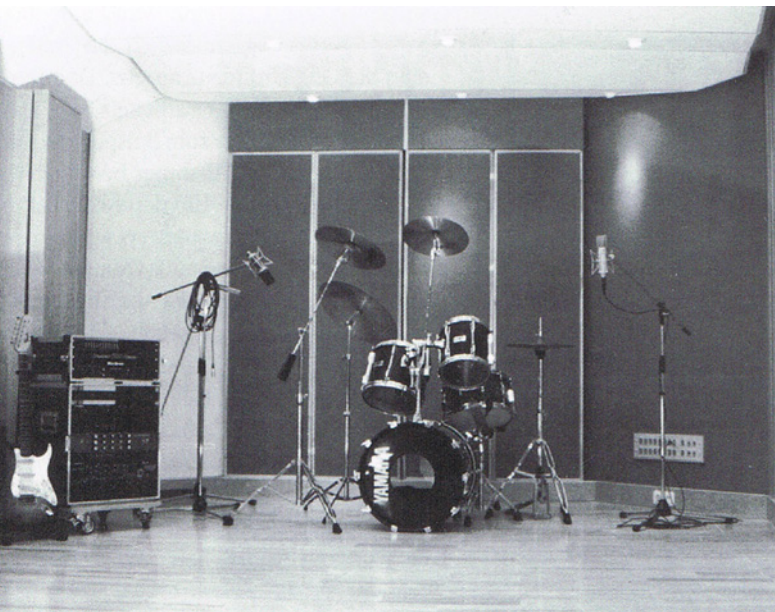
Aufnahmerraum Violet Studio München: Hinter dem Schlagzeug erkennt man klappbare Panelabsorber mit wahlweise harter oder poröser Oberfläche
