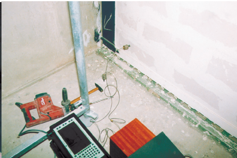
Aufbau einer Schwingungsmessung für einen einfachen Versuch. Zu sehen sind die an Wand und Boden befestigten Beschleunigungsaufnehmer
