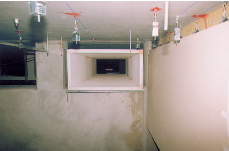
Die vorbereiteten Schwingungsabhänger einer schweren Gipskartondecke
