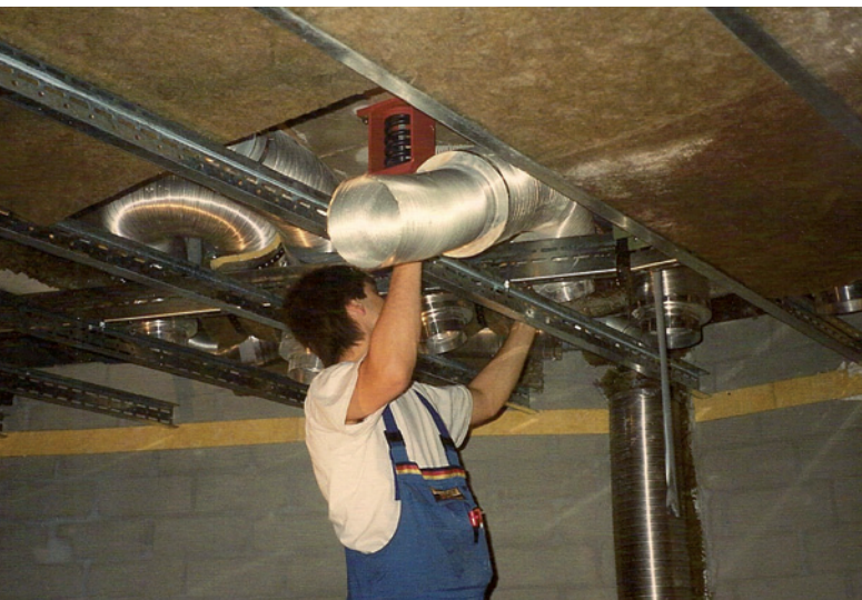
Montage der Klimaanlage in der Violet-Regie
