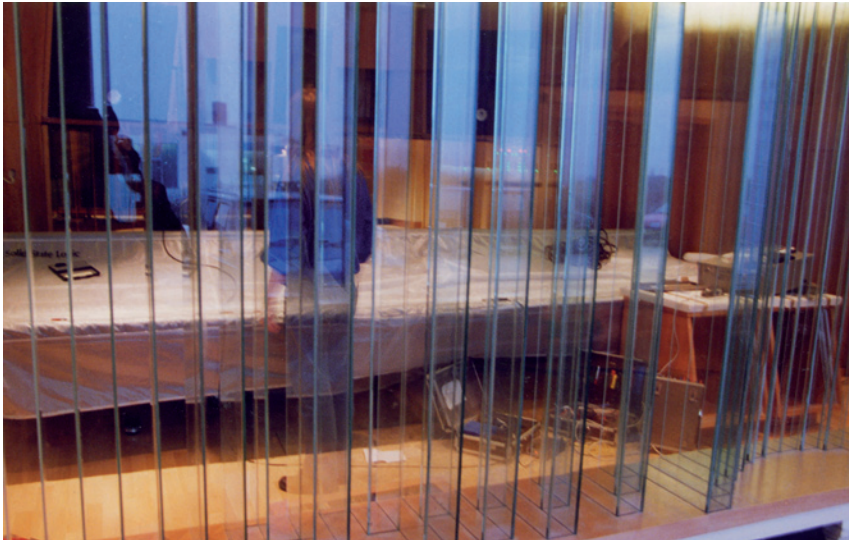
Blick durch die Glasdiffusoren in die große Regie der Cap a Pie Studios in Regensburg
