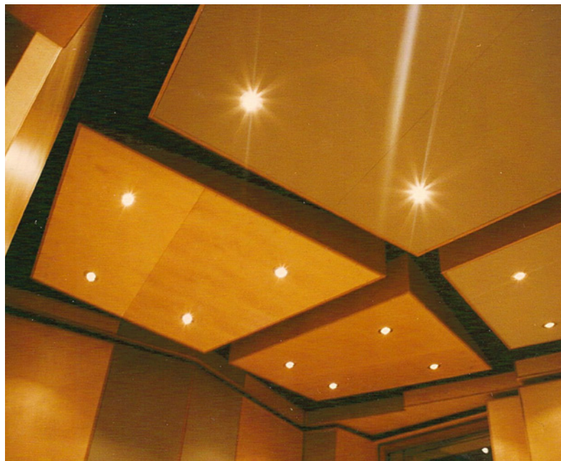
Aufnahmerraum von Walter Gerke's Producer-Studio in Witten: Eine Mischung aus porösen Absorbern und Plattenschwingern an decken und Wänden.
