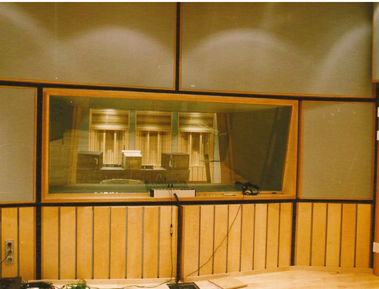
Walter Gerke's Producer-Studio in Witten: Aufnahmeraum mit gemischt ausgelegten Absorbern. Unterhalb der Regiescheibe erkennt man die Schlitzeplatten-Absorber.
