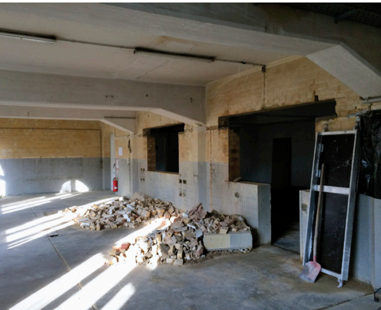
Für die Fenster zwischen dem großen und den kleinen Aufnahme­räumen, mussten Löcher für die Fenster in die Wände gesägt werden, Foto: Echolux
