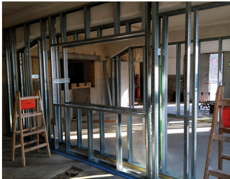
Das Metallständerwerk, Foto: Echolux
