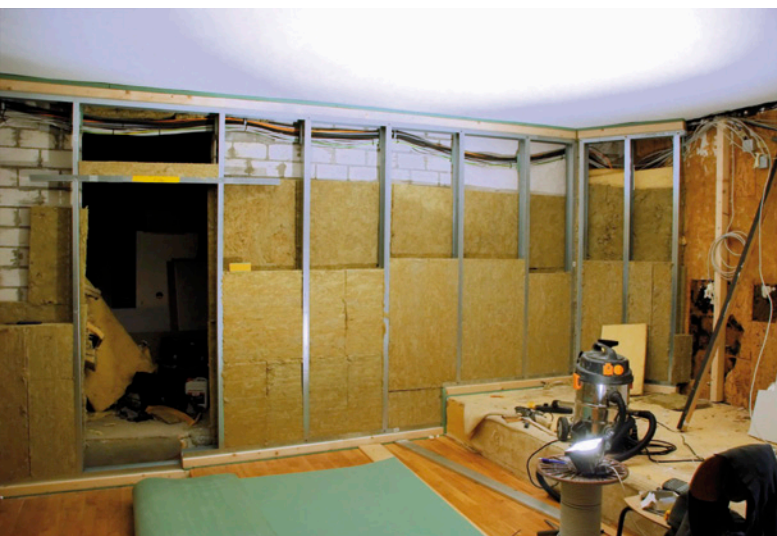
Beginnende Ständerwerk-Arbeiten im Aufnahmeraum
