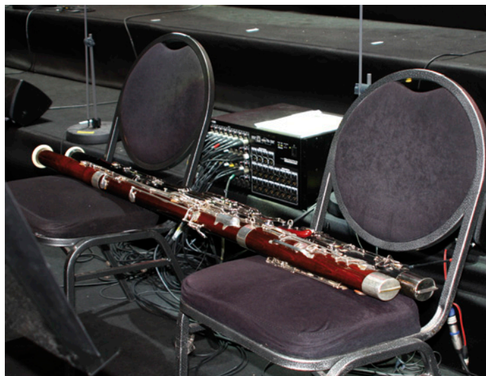
Kohar-Show: Die Stageboxen fanden ihren Platz unmittelbar zwischen den Musikern, um die analogen Strecken so kurz wie möglich zu halten
